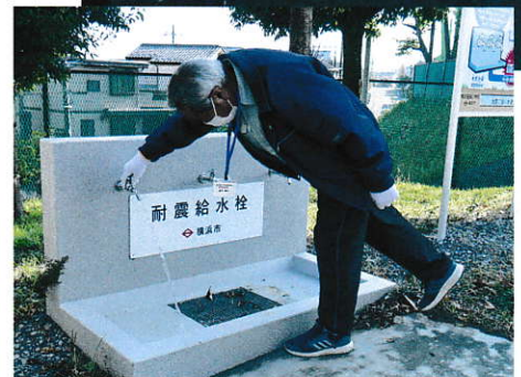
【給水栓の確認】
